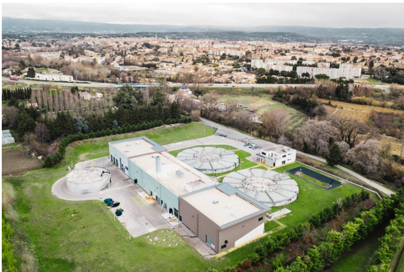
La station d'épuration des eaux usées de Carpentras. © Norman Kergoat
