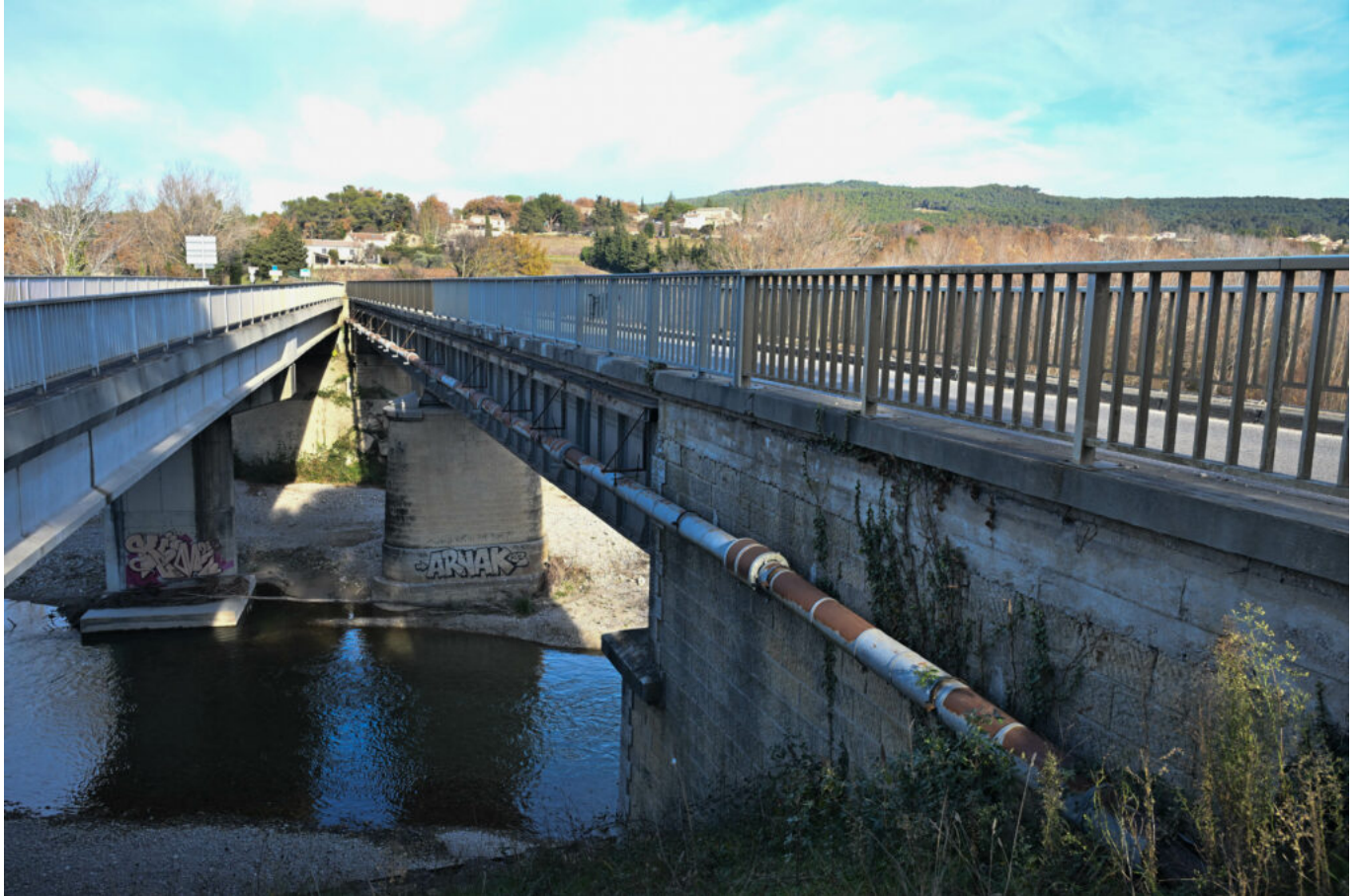
Le pont Valentin (à gauche) et le pont qui va être destiné à la véloroute (à droite). ©Département de Vaucluse
