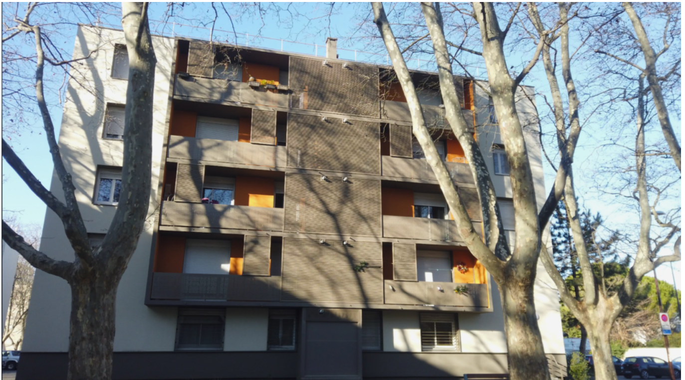
Réhabilitation de Saint-Chamand
