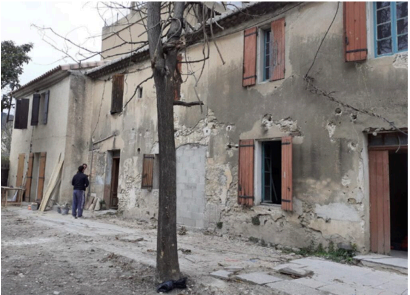
Groupement d'habitations à Châteaurenard avant travaux Copyright Kyaneos
