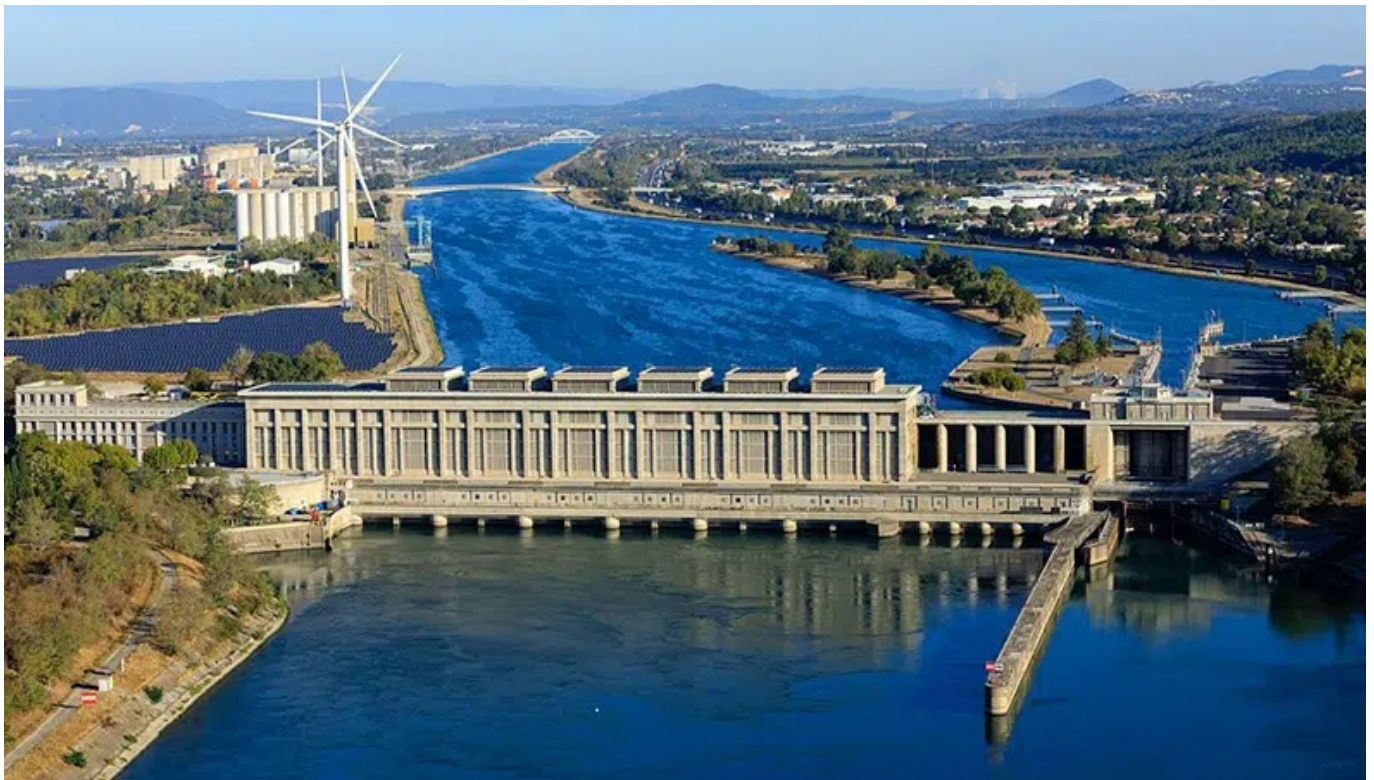
Centrale hydroélectrique de Bollène . ©CNR Bollène
