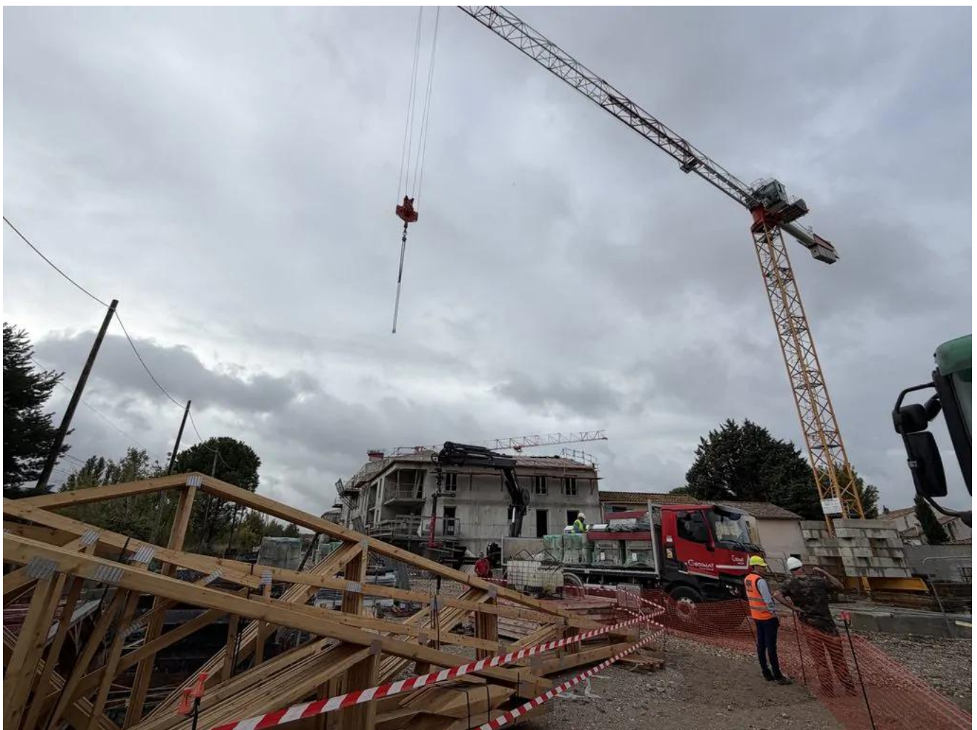
Chantier Coulisses du bâtiment 'Toits de Corleudone' Copyright Mireille Hurlin
