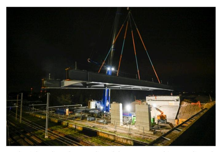
Dans la nuit du mardi 2 avril au mercredi 3 avril, des travaux spectaculaires ont eu lieu sur le chantier de la déviation d'Orange puisque la charpente métallique du nouvel ouvrage franchissant la voie ferrée a été posée sur ses appuis grâce à deux grues. L'opération a nécessité une coupure totale de circulation des trains, programmée il y a trois ans avec la SNCF.
