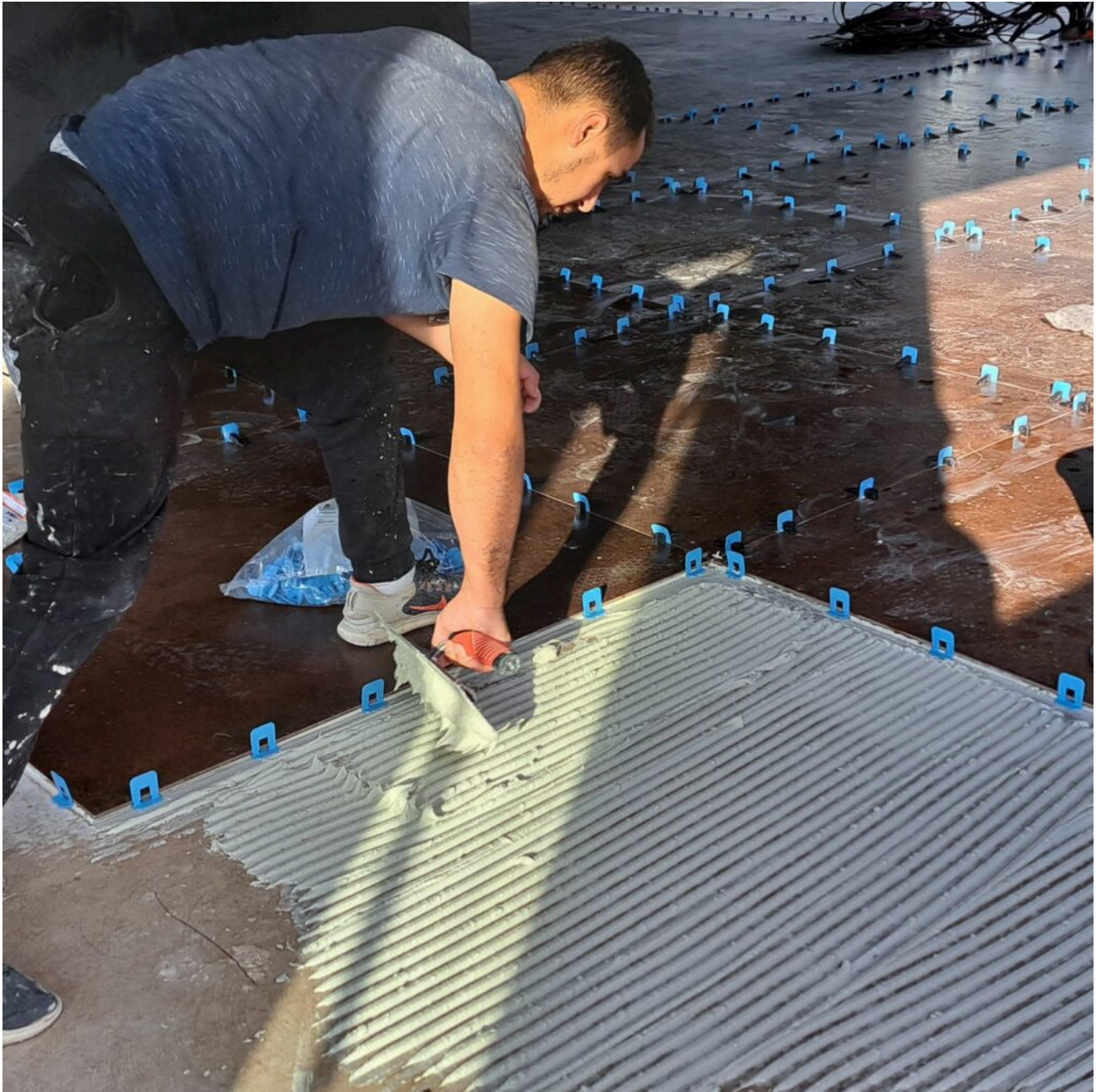
Pose du carrelage ©AB/L'Echo du Mardi
